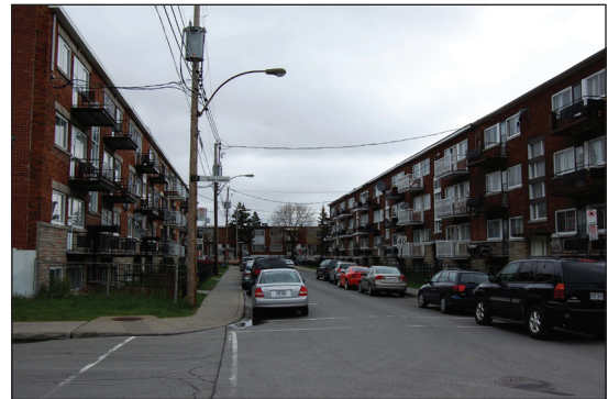
Photo 5 : Bloc d'appartement situés dans le secteur du boulevard Pie-IX
