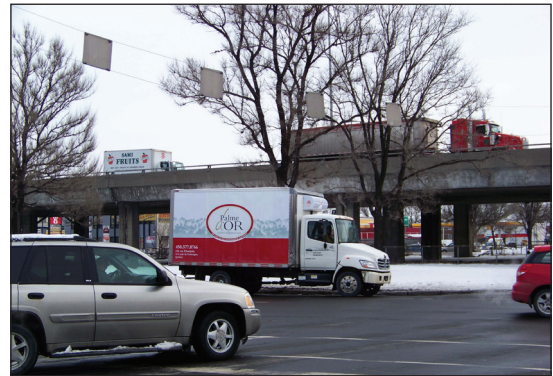
Photo 6 : L'autoroute métropolitaine dessert une circulation lourde composée en partie de camions
