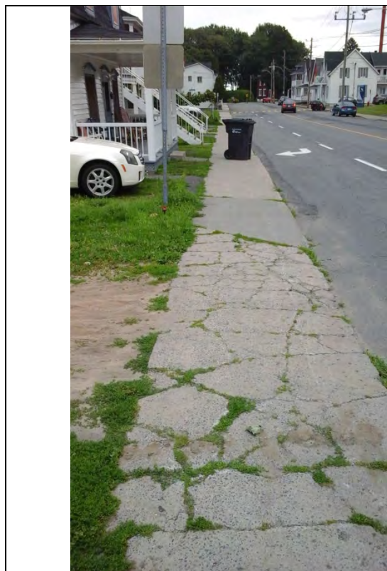
Photo n°1 – Trottoir en mauvais état (source : H. Touman)
