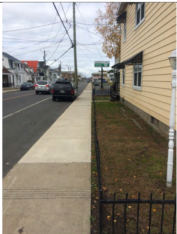
Photo n°2 – Trottoir en bon état (source : H. Touman)
